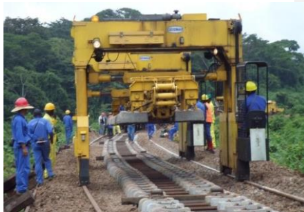
Figure 5 : Portique de renouvellement pour pose de traverses
